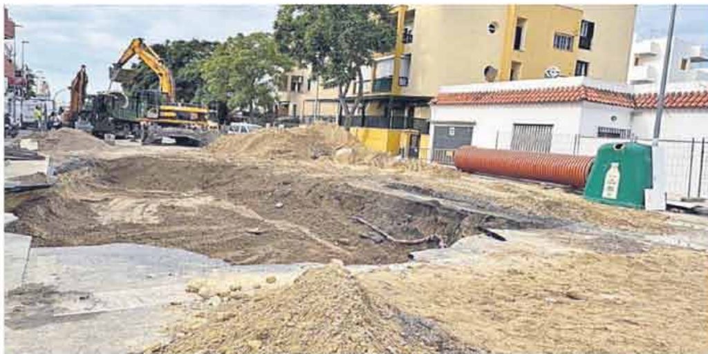
Aspecto del socavón de Las Piletas una vez arreglada la avería en el colector.
